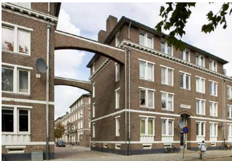
Schutterswijk Gorinchem, Overzicht gevelwand met poort, Collectie Rijksdienst voor het Cultureel Erfgoed, objectnummer (20421661)
